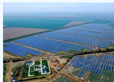
匈牙利 考波什堡 100MW 光伏电站项目
