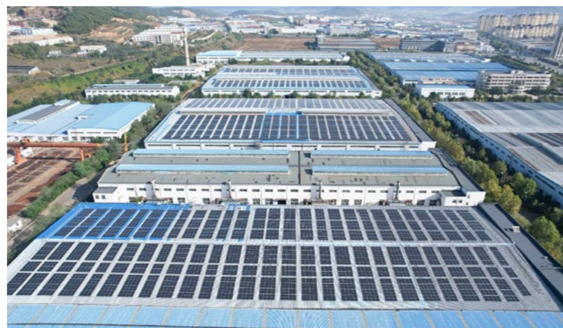
通用技术大连机床 18MWp 分布式光伏电站每年减少 CO 2 排放量约 2.07 万吨
