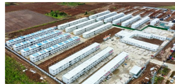
通用技术新兴公司援建泰安市岱岳区方舱医学隔离点
