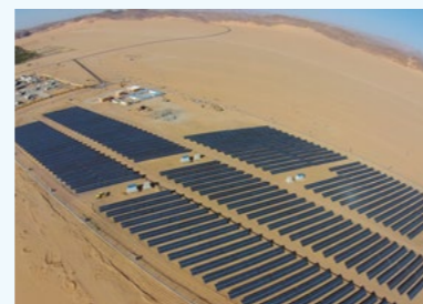
阿尔及利亚 25MW 光伏电站项目
